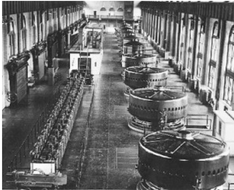
Motores A.C de Tesla dentro da estação e geração de energia de Niágara Falls
